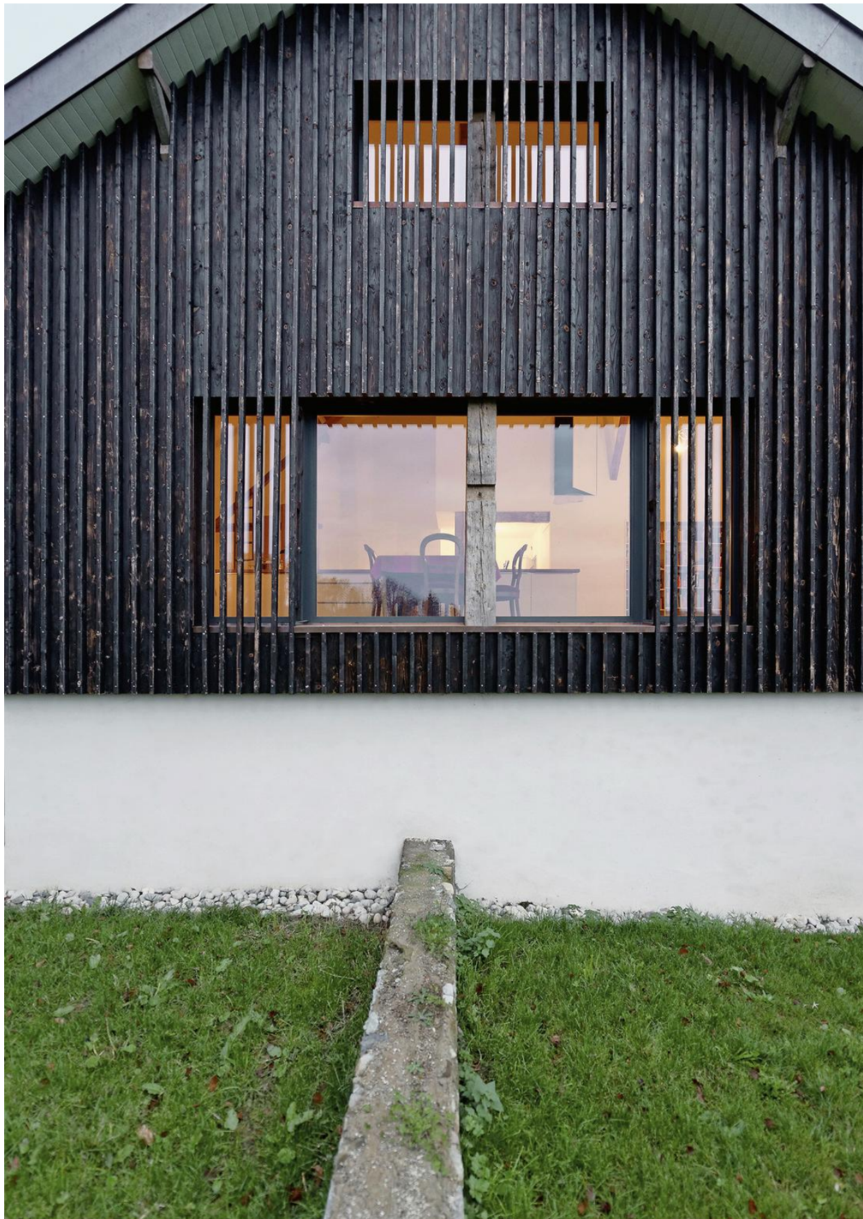
La technique du bois brûlé japonais permet de maintenir les bâtiments dans ses caractéristiques anciennes. Ici la façade d'une ferme reconstruite à Montheron. PHOTOS FRED HATT
